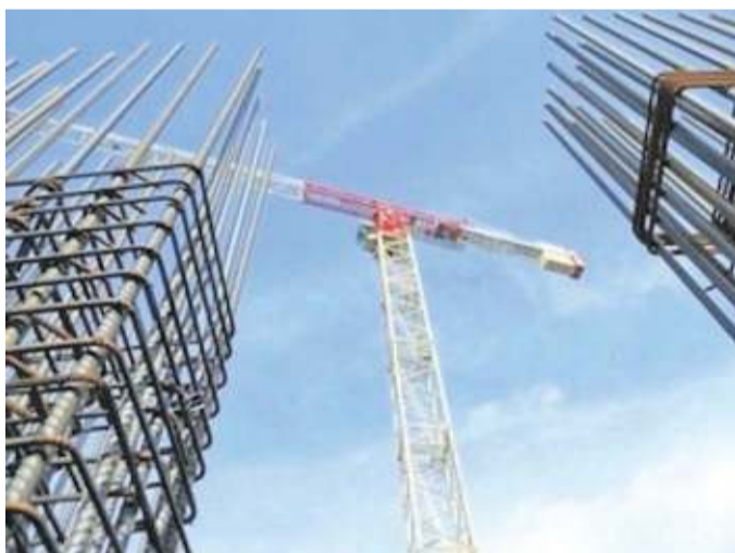
Un cantiere edile
